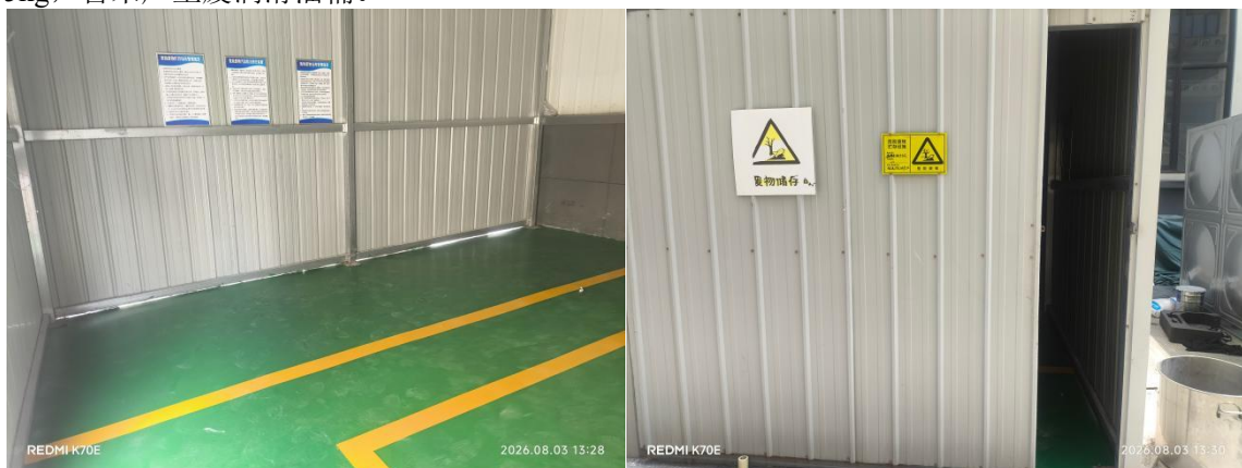
图 3.4-1 项目危废仓库建设实况
