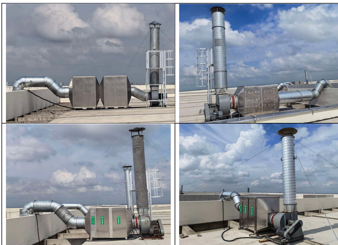
图 3.1-2 废气处理装置图
