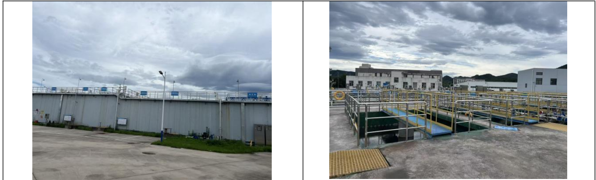
二期工程主体
