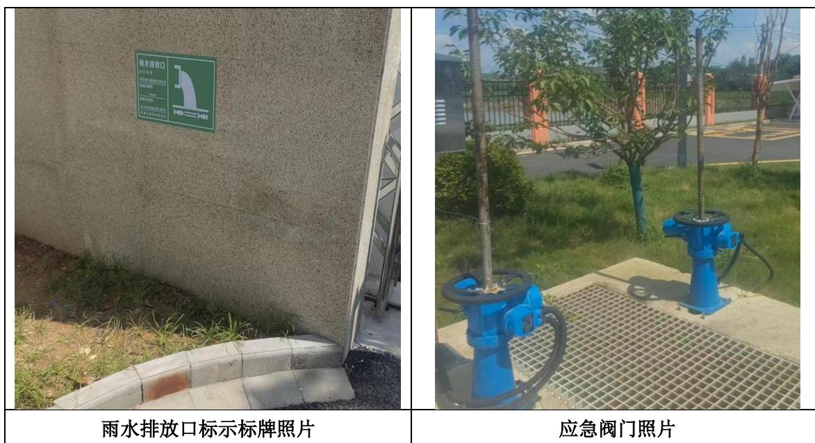
图 4.2.2-2 雨水排放口标示标牌、应急阀照片
