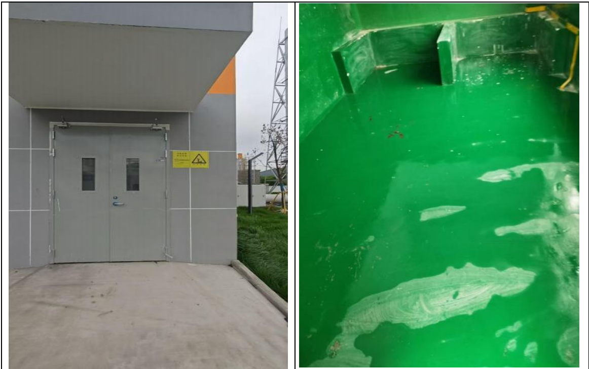
危废暂存库照片
