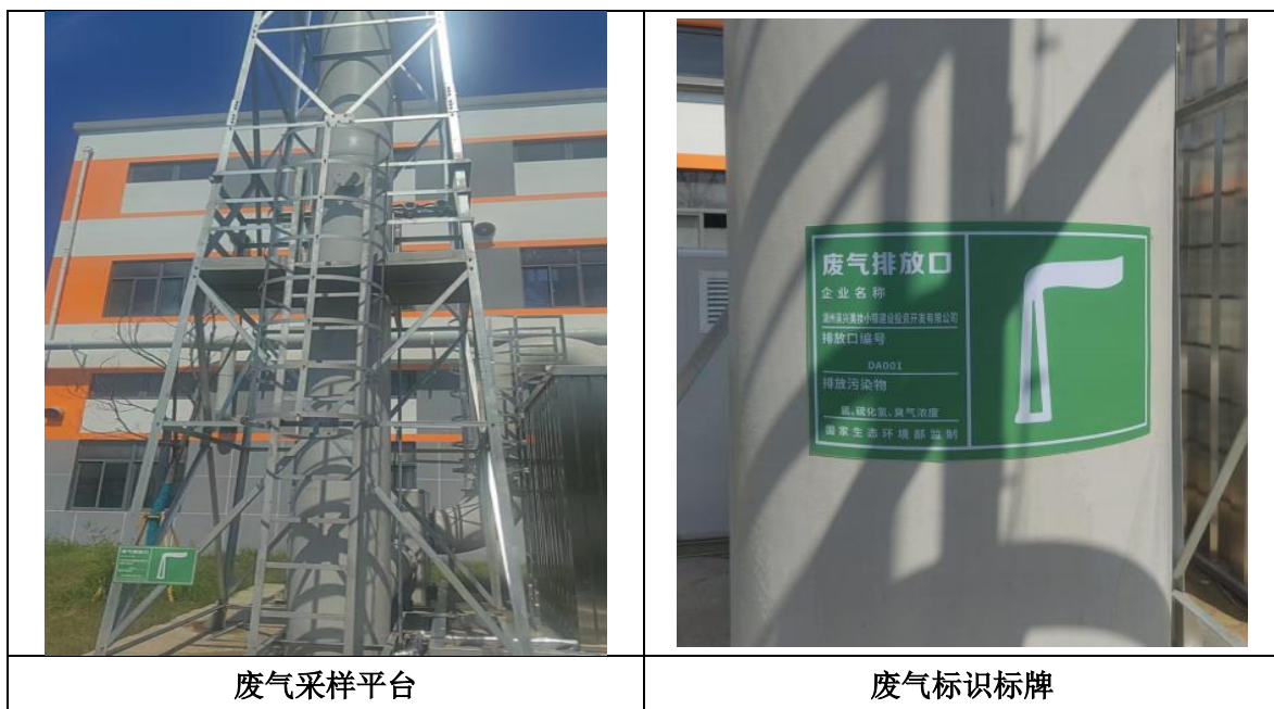
图 4.2.2-3 废气采样平台及标牌照片
