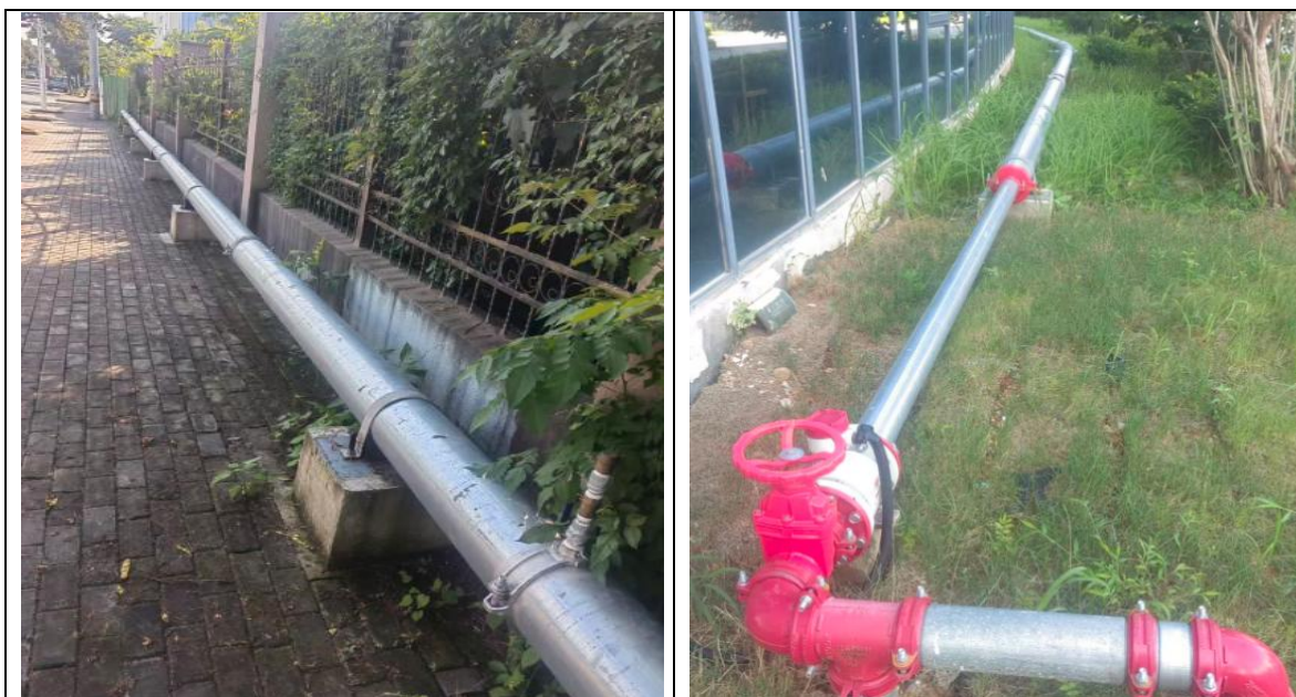
管道架空照片
